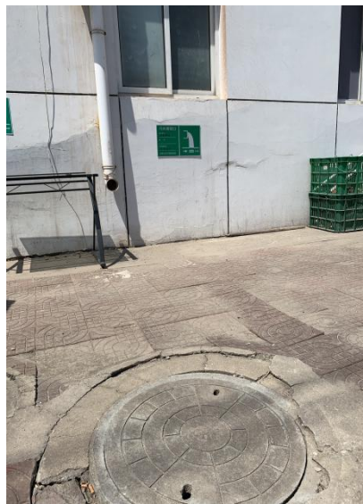
污水总排口标志牌
