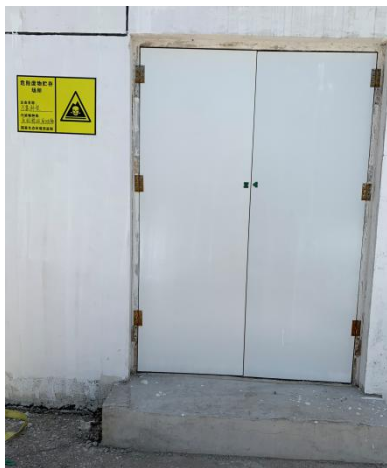
危险废物贮存间
