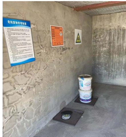
危险废物贮存间内部
